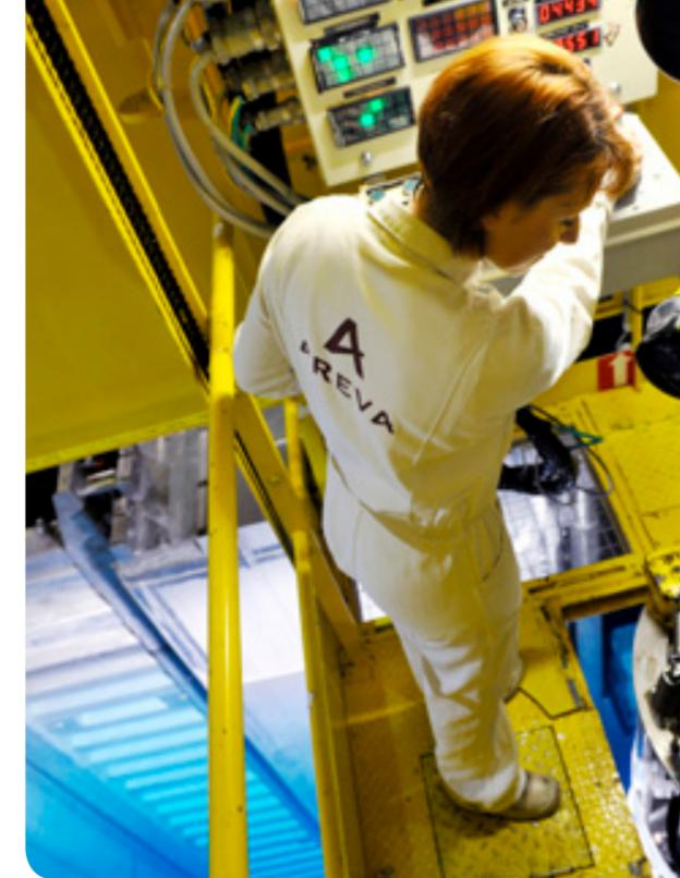
> Conduite du pont de manutention d'une piscine d'entreposage du combustible usé.
