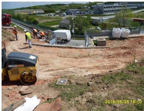
Du 25 au 26/05/16 : reprofilage des terrains et mise en place d'une noue facilitant la gestion des eaux de surface en arrière de la CD11 en respectant les pentes transversales et longitudinales prédéfinies.
