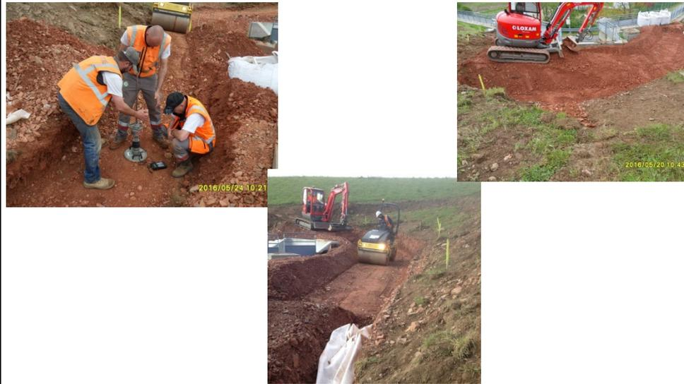
23/05/16 : mise en place du remblai compacté par couches successives de 20 cm en 8 passes avec un compacteur à bille lisse, sans vibration.
