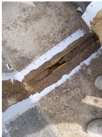
**Photo 3-6 : Disjonction du raccord du fossé 110 -111 Ouest**
