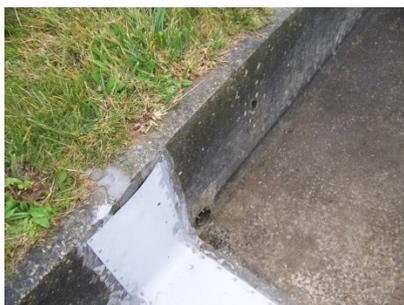
**Photo 3-7 : Réparation du raccord de fossé 110-111 Ouest**
