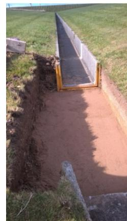
**Photo 3-4 : Fossé du panneau 108 Est - reprise du plan de pose sous l'élément béton levé**
