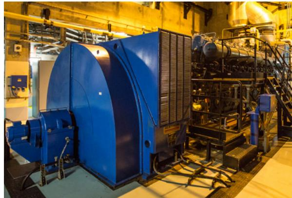
Groupe électrogène de secours à moteur Diesel de la centrale nucléaire de Penly
