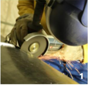
1 Élimination du défaut par affouillement
