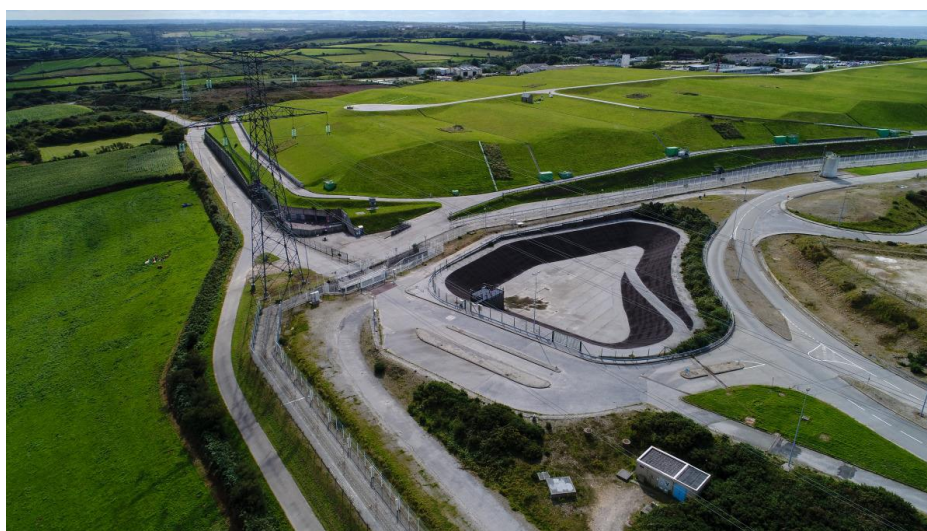
Figure 4-9 Bassin d'orage du CSM
