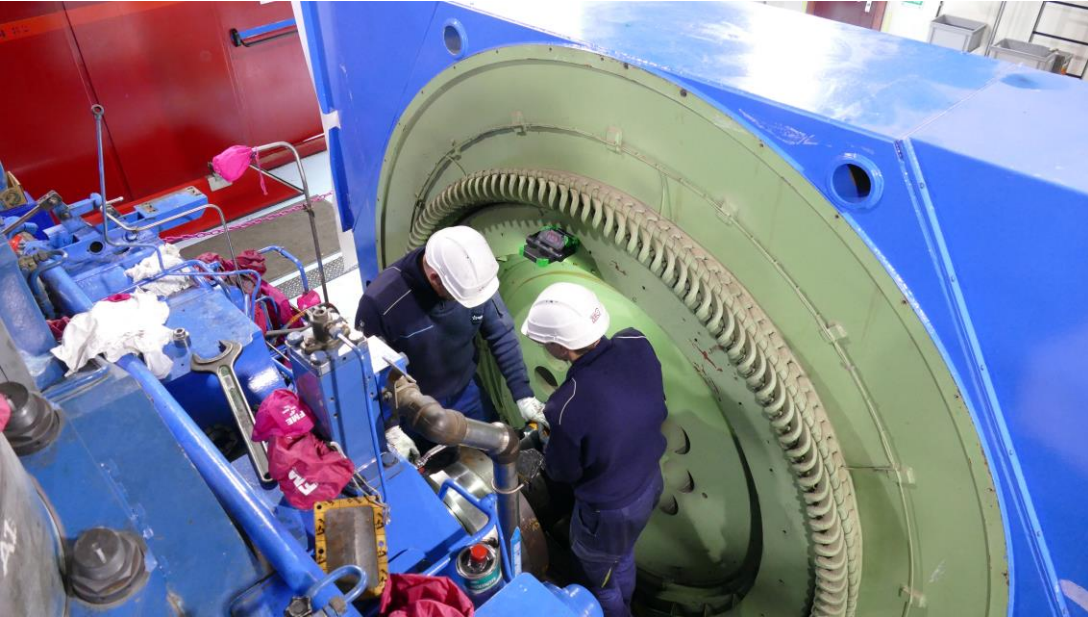
Remplacement de l'alternateur (55 tonnes avec le châssis)
