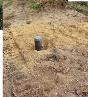
Forages des avant-trous et pose des tubes guides
