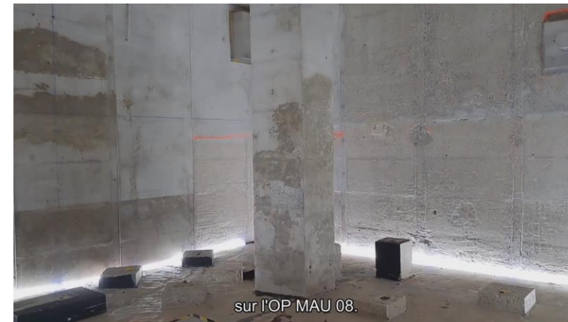
Cellule 900 après écroutage GC
