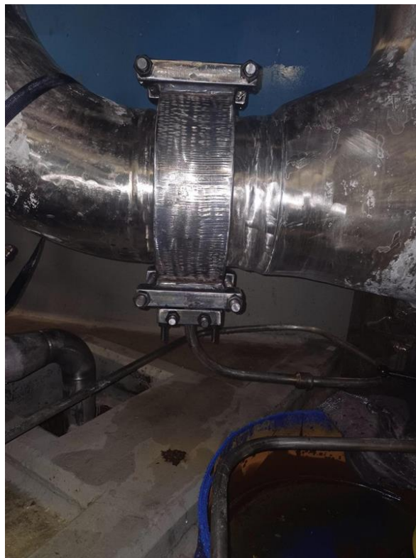
Réalisation par PRESTO FUITEs
